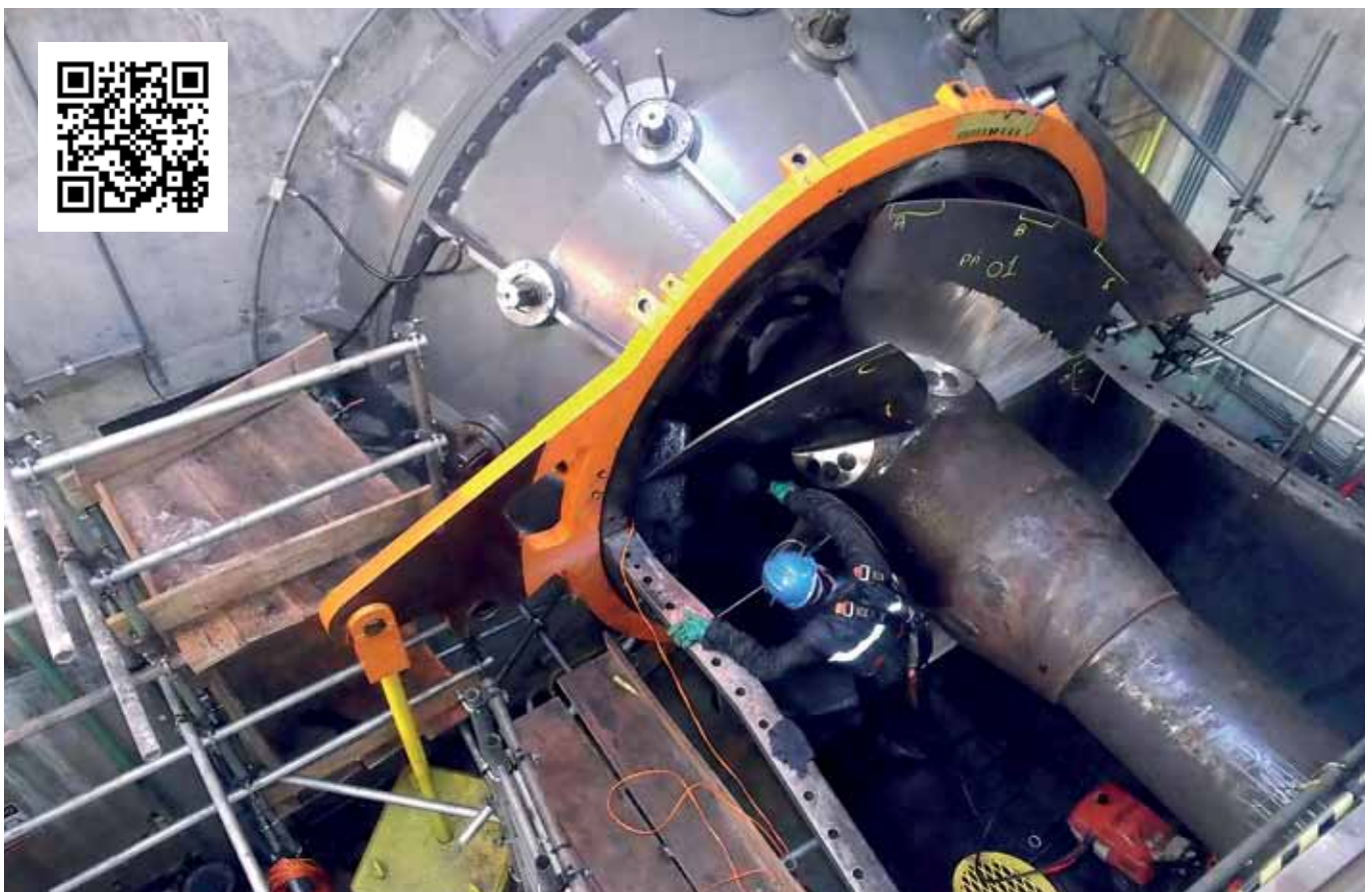
▼ Обслуживание РК поворотной-лопастной турбины на ГЭС «Mogi Guacu»
