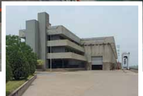
▲ Здание ГЭС с четырьмя гидроагрегатами
