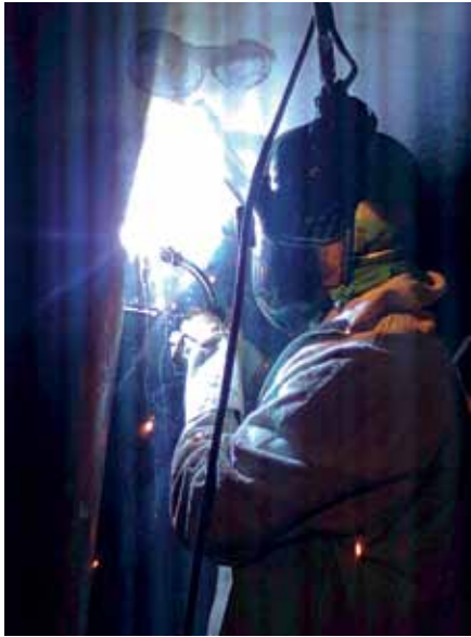
▲ Устранение последствий кавитации на ГЭС «Taquarucu»
