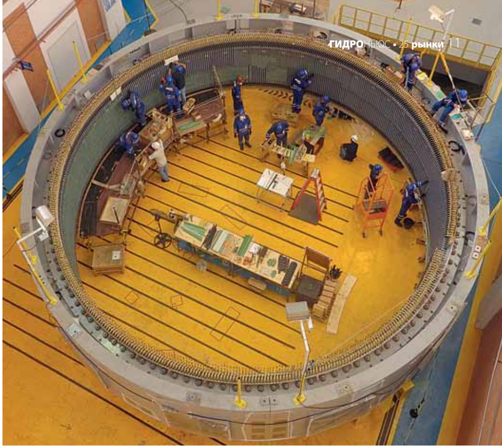
▲ Сборка обмотки на ГЭС «Cachoeira Dourada»
